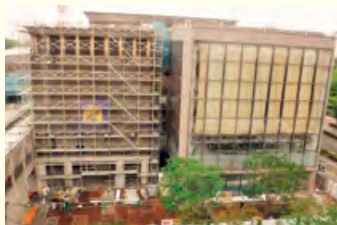
全体が足場に覆われた大ホールのエントランス
